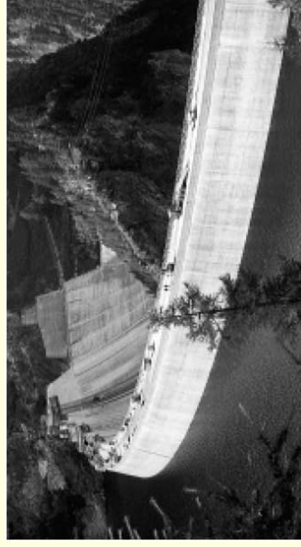
Figur 4: Bogen-Staumauer Luzzone während der Erhöhung
